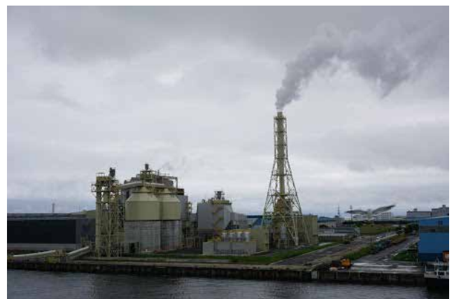
写真:2017年10月1日に営業運転を開始した仙台パワーステーション 1
