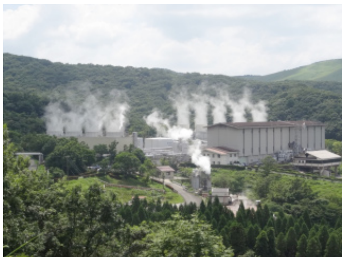
写真 10: 八丁原発電所(出力 11 万 kW、大分県九重町)
