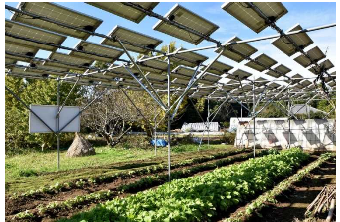
図2 発電設備の下で栽培される作物
