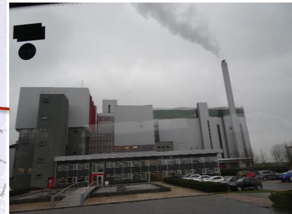
7.廃棄物CHP(60MW) DHの約25%を供給
