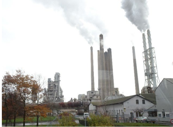
3.セメント工場の排熱 (DHの約20%を供給)
