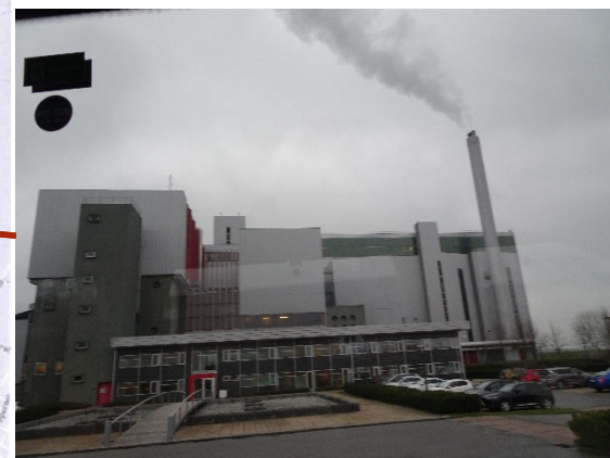
7.廃棄物CHP(60MW) DHの約25%を供給
